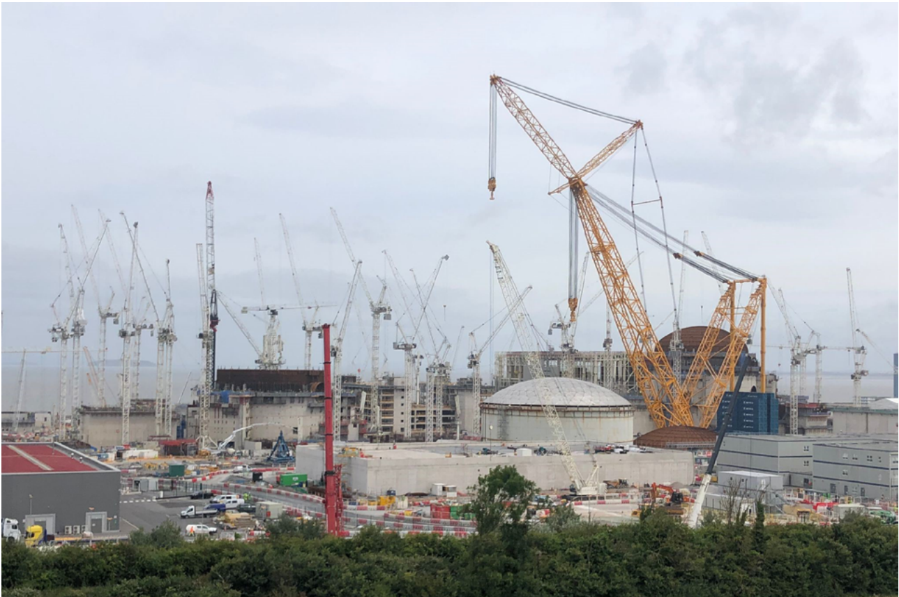
Figuur 6.6: foto van de bouw van Hinkley Point C
